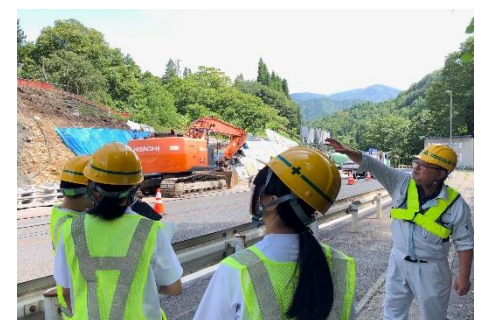
8/22 工事現場で説明を受ける生徒 （神岡町梨ヶ根地区にて）
